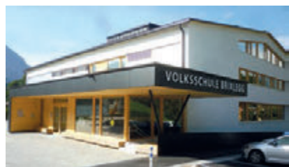
Volksschule Brixlegg - Mustersanierung
