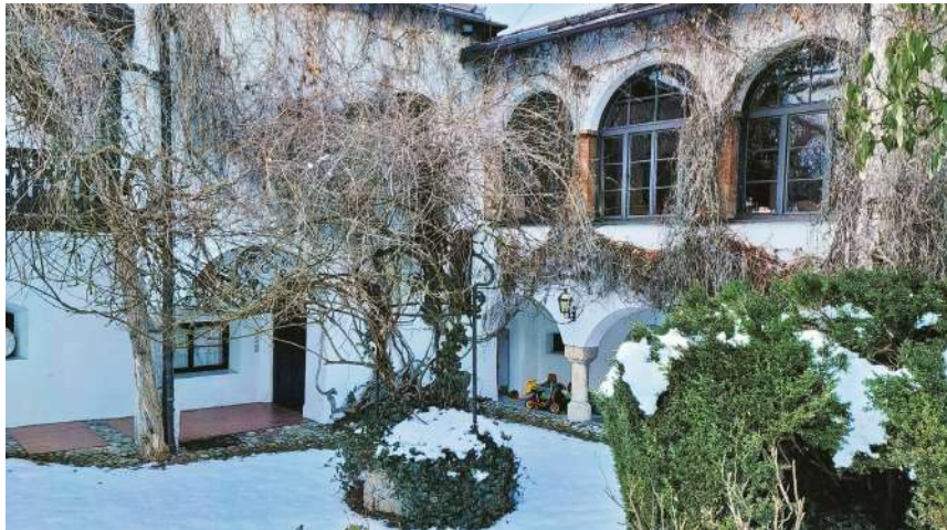
Burg Marquartstein Innenhof Süd- u. Westtrakt mit Zisterne
