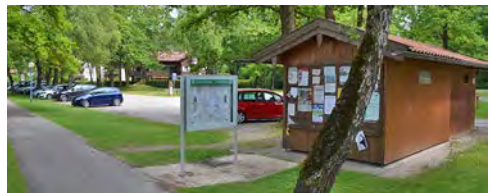
Infotrine mit Fahrradgarage + WC in Seebuck
