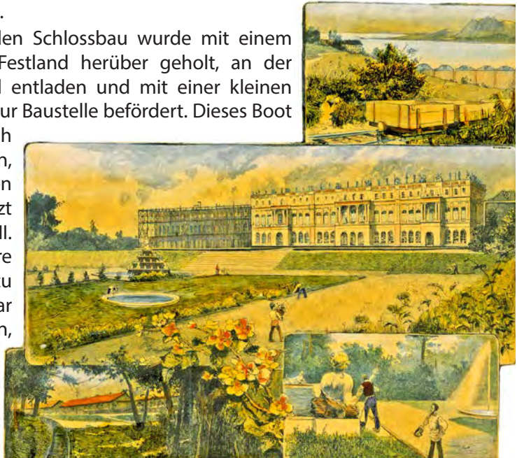
Kolorierter Stich der Schlossbaustelle um 1885
